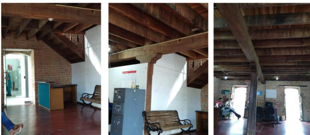
Se registra el deterioro interno del Edificio el triunfo, donde se evidencia el avanzado estado de deterioro que tienen los entrepisos en madera. También se identifica las modificaciones que tiene la fachada principal en el primer piso.
