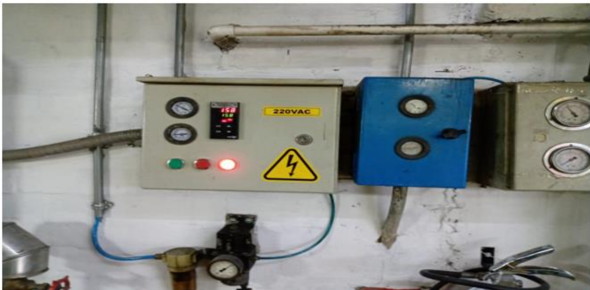
Figura 4-3: Transductor de presión neumática.
