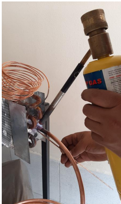
Figura 4-3: Soldadura tubería de cobre.
