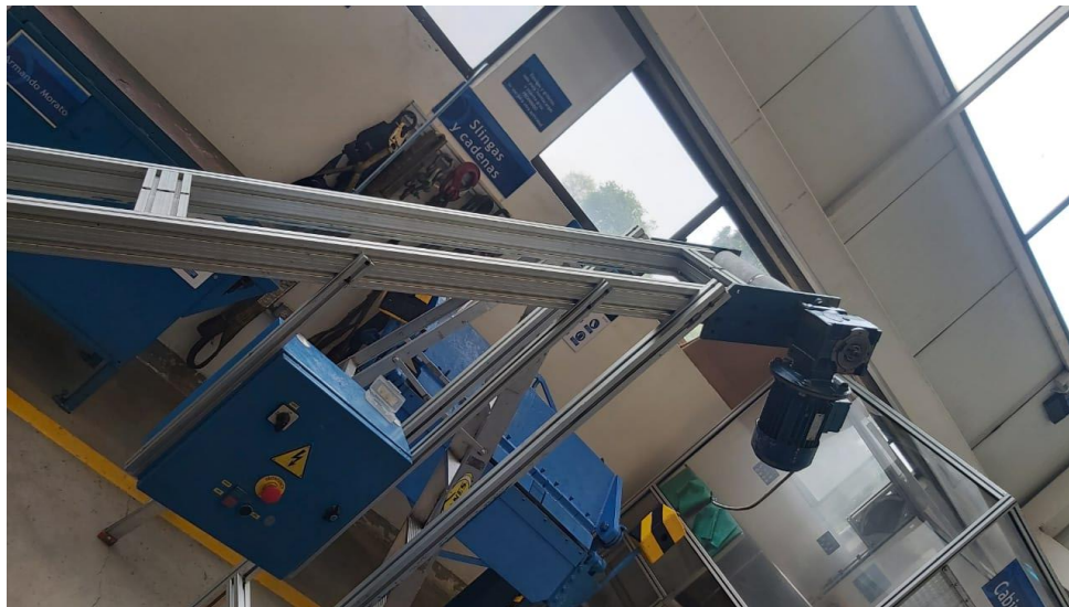
Figura 53. Montaje tablero eléctrico y sistema motriz
