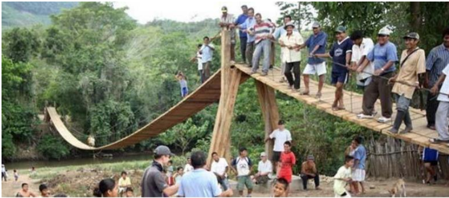
Figura 28. Puente colgante Tres unidos. Peru. Fuente: (Soley Salamero, 2012).
