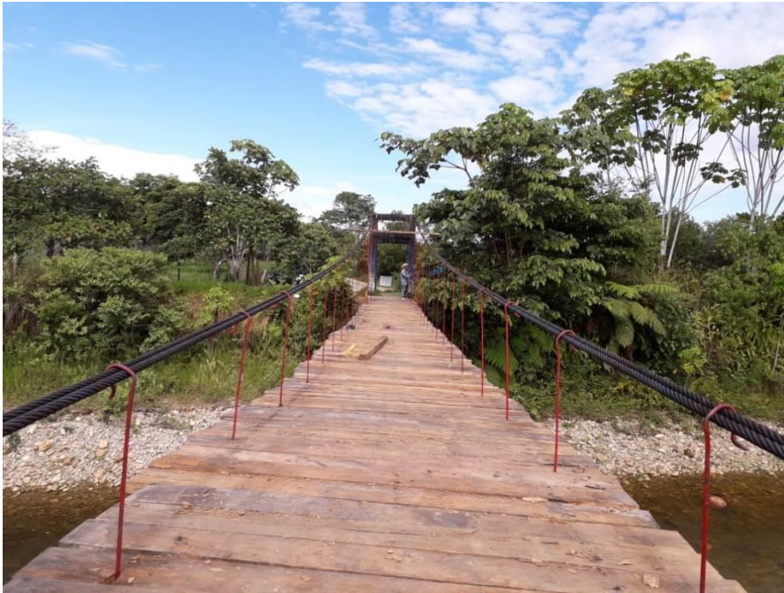
Figura 14. Tablero de madera en un puente colgante. Fuente: Propia.
