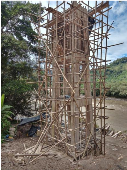
Figura 49. Construcción de torre para puente colgante. Fuente: Propia.
