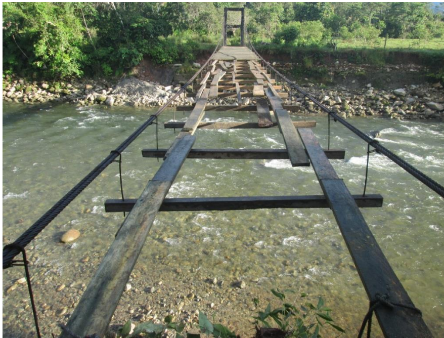
Figura 50. Implementación del tablero puente colgante. Fuente: Propia.
