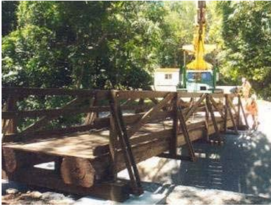
Figura 34. Puente en madera. Fuente: (Soley Salamero, 2012).
