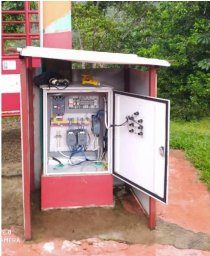
Figura 23. Sistema de control. Fuente: Propia.
