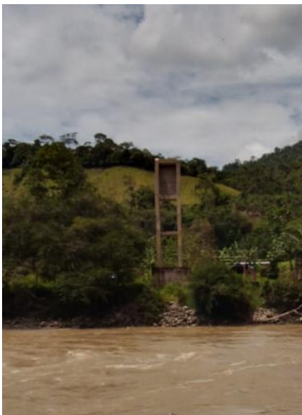
Figura 12. Torre para puente colgante. Fuente: Propia.
