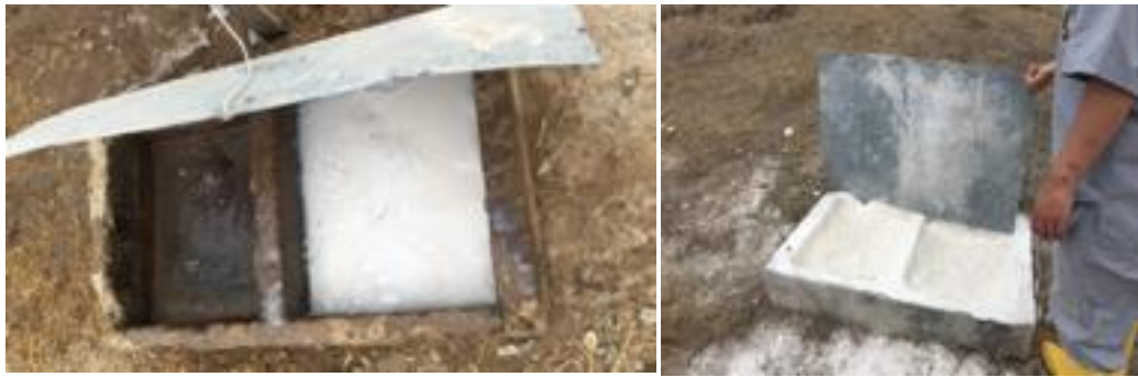
Evidencia# 7. Pediluvios entrada de cada módulo.
