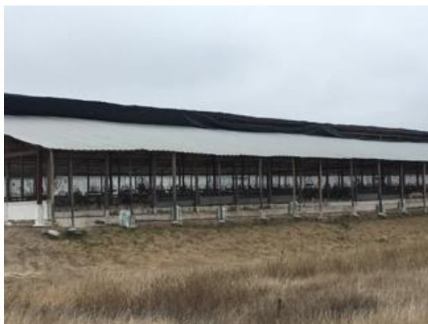
Evidencia# 8. Techo en buen estado modulo B y C de la granja Santa Elena.
