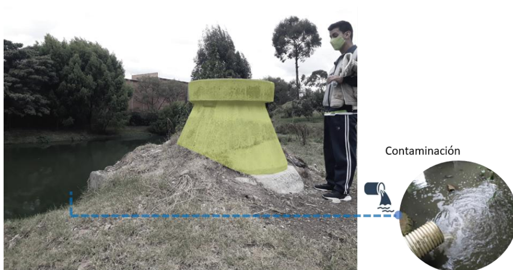
Figura 12. Vertimientos de aguas negras, humedal La Vaca sector norte.
