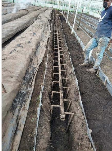
*Figura 18 - Montaje de rastrillos de tuberías perforadas enterradas actualmente en Flexport (Autor).*
