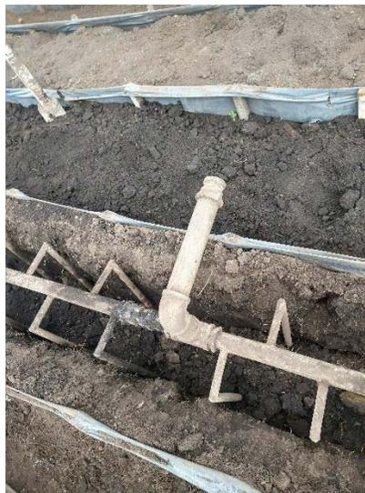
*Figura 19 - Entrada principal de vapor desde la caldera por medio de mangueras de Ø2 in (Autor).*
