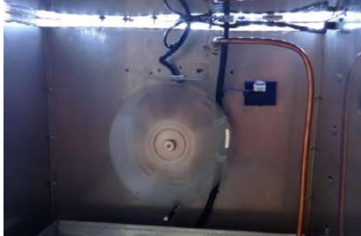
Figura 38 Montaje regleta led
