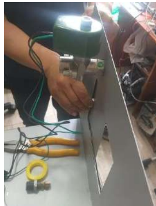
Figura 36 Montaje de válvula solenoide
