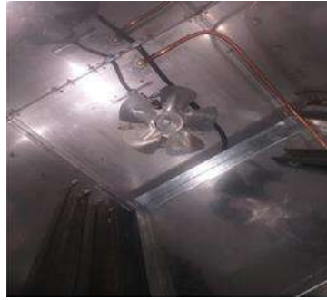
Figura 35 Montaje motor ventilador
