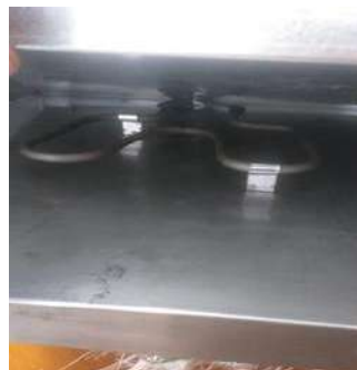
Figura 34 Montaje de resistencia tubular.
