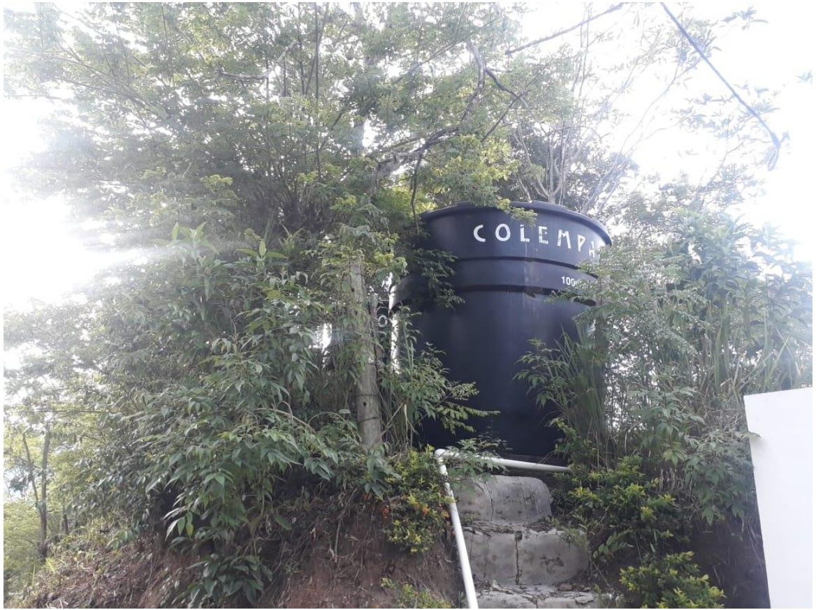
Figura 30. Tubo de llegada a los tanques de almacenamiento. Fuente: Propia
