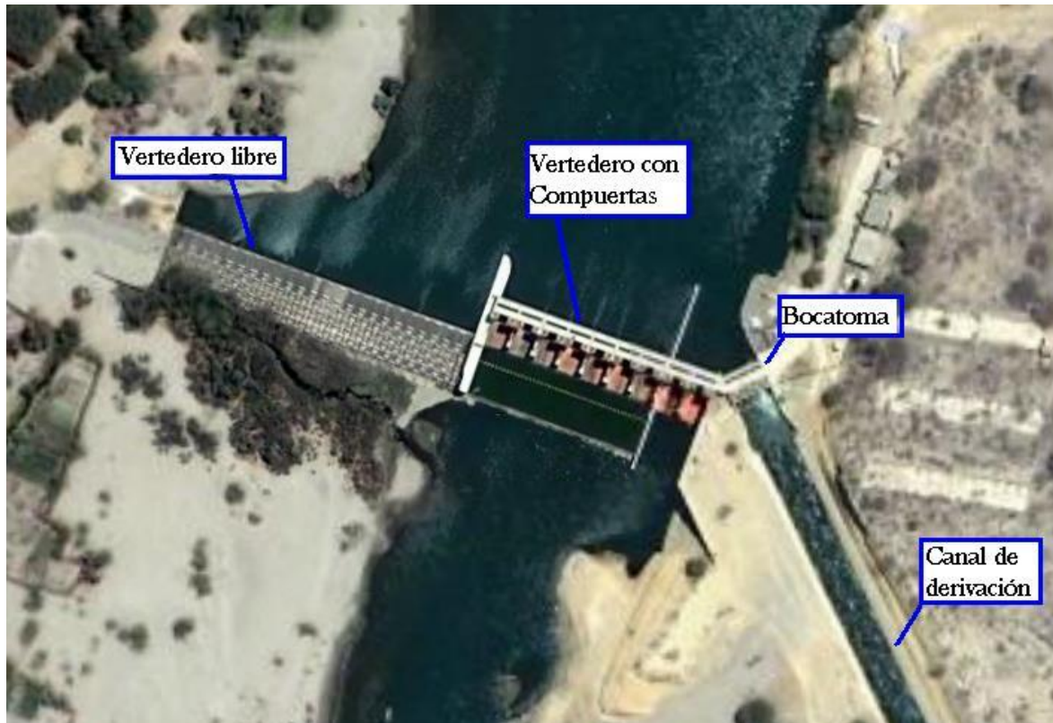
Figura 5. Bocatoma Fuente: (Wikipedia, 2019)
