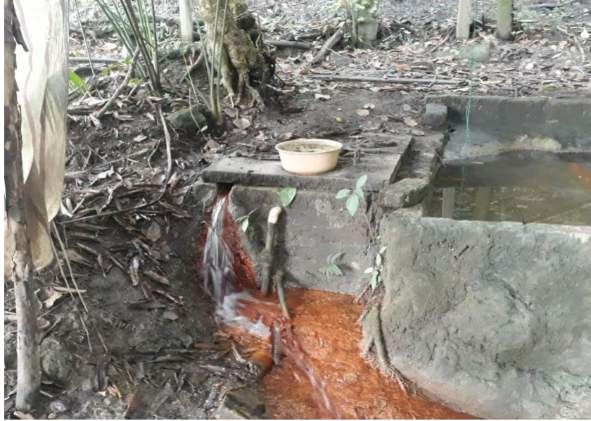
Figura 26. Captación directa Fuente. Propia
