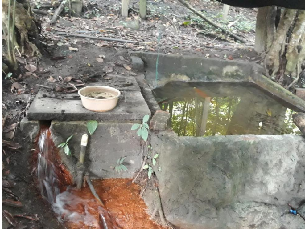
Figura 7. Captación directa Fuente. Propia
