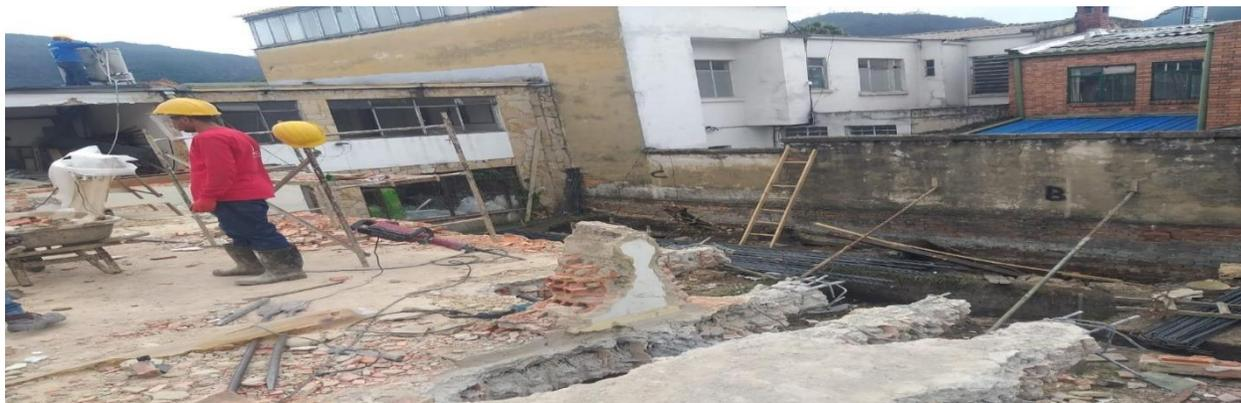
Los avances de obra en demolición y excavaciones inician del costado sur de la obra hacia el frente para poder utilizar los muros frontales como protección para evitar intrusos en el predio como se registra en la **Figura 24**.
