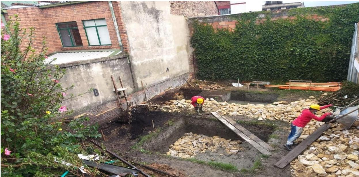
Paralelo a la actividad excavación se continuaba con la demolición, se demuele la placa del primer piso con un espesor de 0.25 m con viguetas cada 30 cm, en la **Figura 21** se evidencia estos parámetros.
