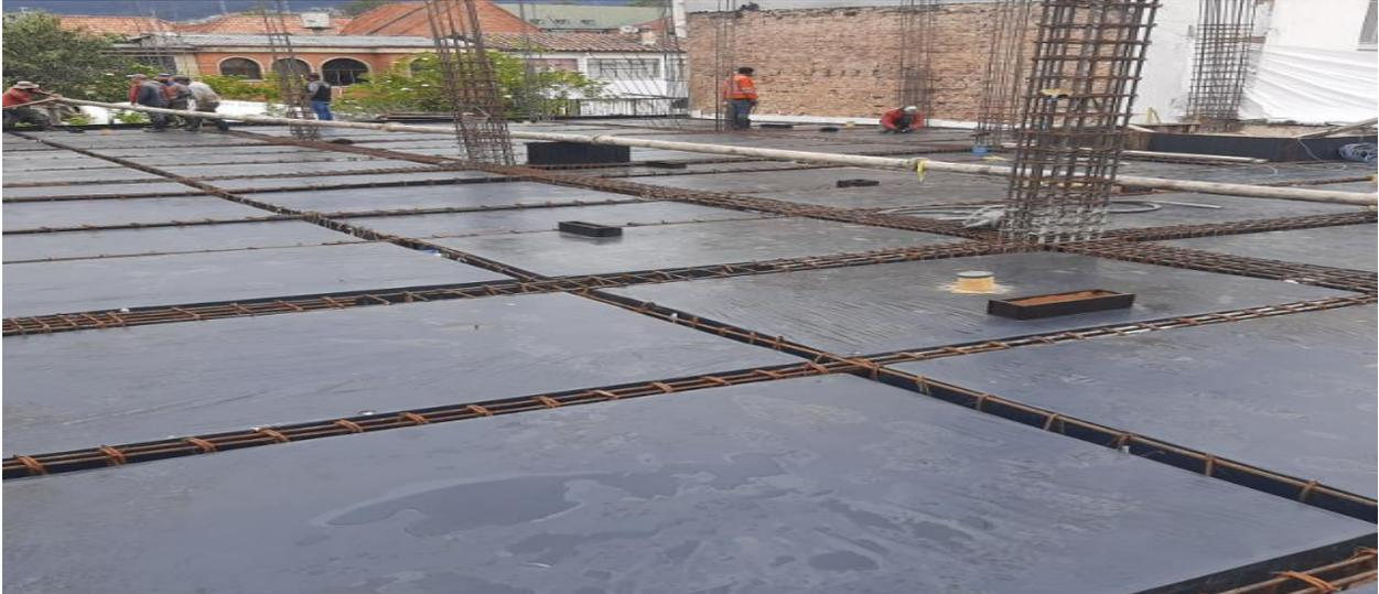
Viga perimetral con dimensiones de 0.45m\*0.35 m, riostras de 0.15m\*0.35m y viguetas de 0.25m\*0.35m. Ver **Figura 32**
