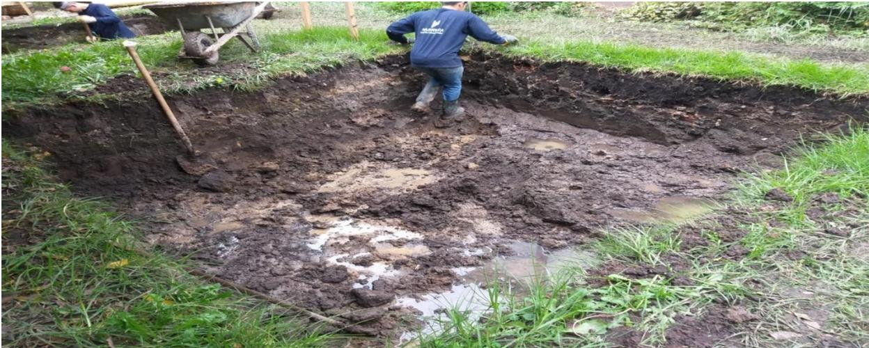
Después de tener una profundidad de 1.45 m, se procede a fundir la parte de ciclópeo, que corresponde a 0.45 m, como se relaciona en la **Figura 20**.
