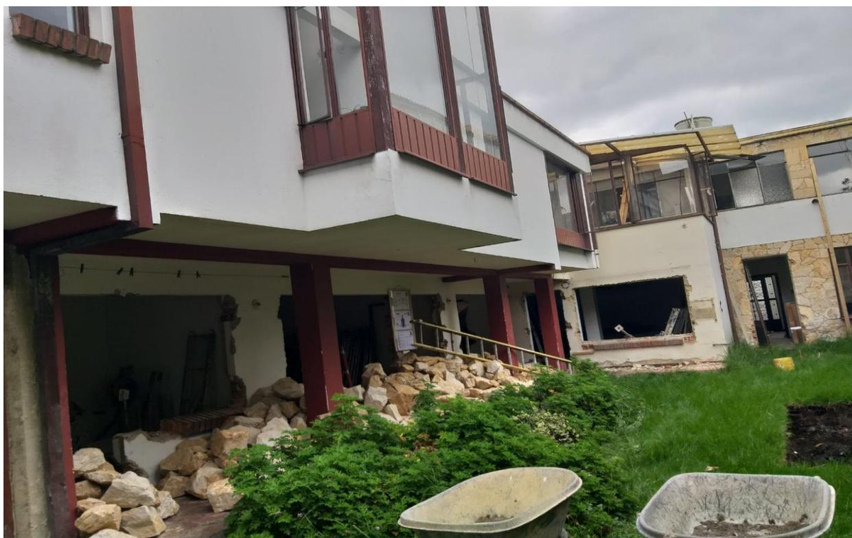
Se ubican los ejes longitudinales y transversales del predio para iniciar la actividad de descapote de las zapatas como lo muestra la **Figura 17**.
