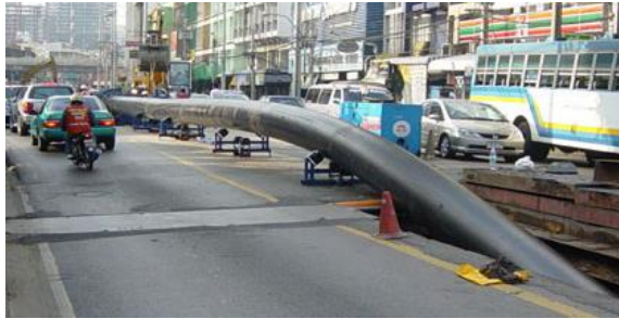
Figura 6 Revestimiento deslizante continuo. Fuente (Terraigua,2011b)
