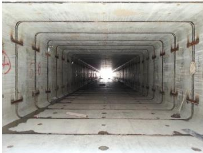
Figura 17 Paso subterráneo peatonal terminado. Fuente (Zhang et al., 2016)
