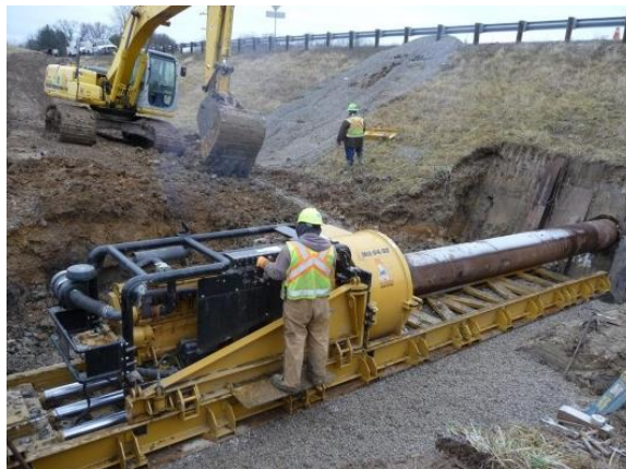
Figura 10 Perforación de barrena horizontal. Fuente (Onsarigo & Adamtey, 2020)
