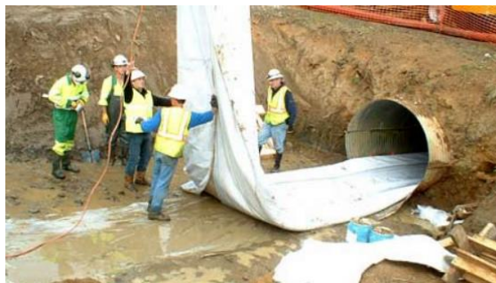
Figura 7 Colocación tubería polimerizada in situ Fuente (Terraigua, 2011a)
