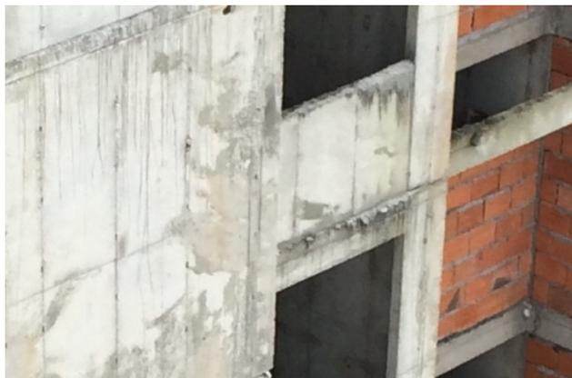
Figura 1 Ejemplo 1 del mal uso de las formaletas
