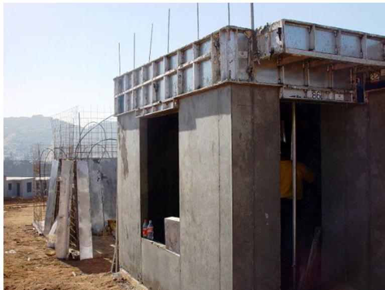
Figura 9 Sistema de formaleta usado en placas de entrepiso
