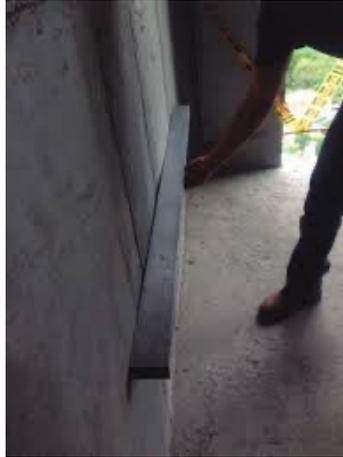
Figura 22 Efecto de ondulación en los muros
