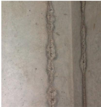
Figura 25 Efecto de sangrado en el concreto
