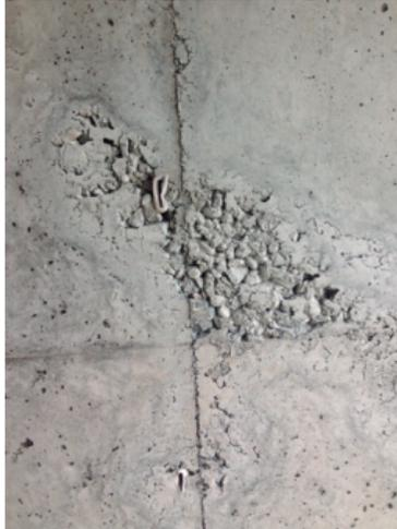
Figura 26 Efecto de hormigueros en el concreto
