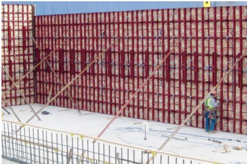
Figura 8 Sistema de formaleta usado en muros
