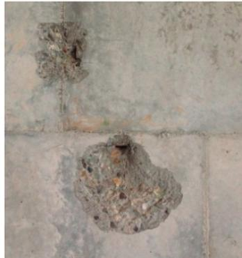
Figura 27 Efecto de Descascaramiento del concreto
