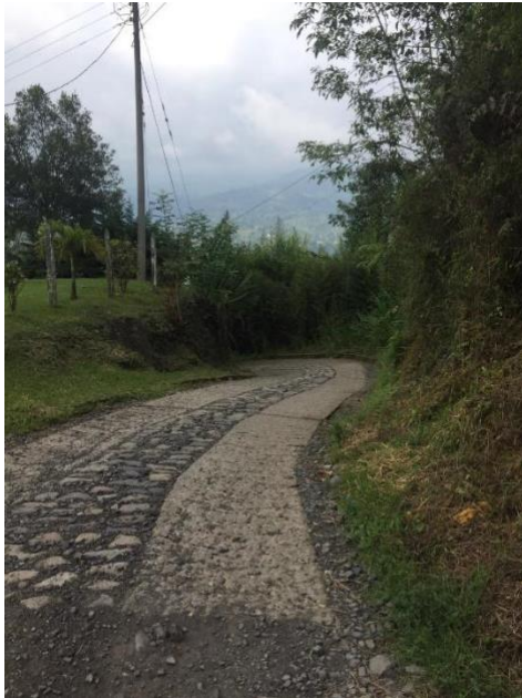
Figura 26 placa huella vereda Arrayán antes de llegar a la escuela fuente elaboración propia
