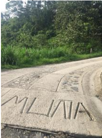
Figura 20 placa huella vereda Muña sector restaurante fuente elaboración propia
