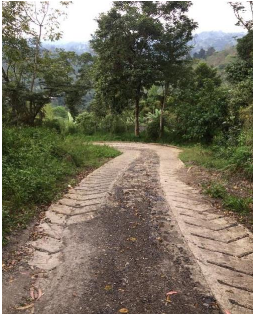
Figura 50 placa huella vereda Toriba sector vía Maritza Forero fuente elaboración propia
