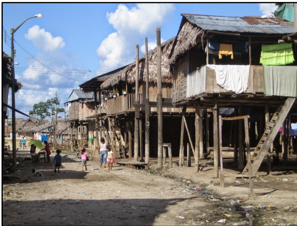
Ilustración 1: Casas palafíticas en la Amazonía en periodos de aguas bajas o de sequías.
