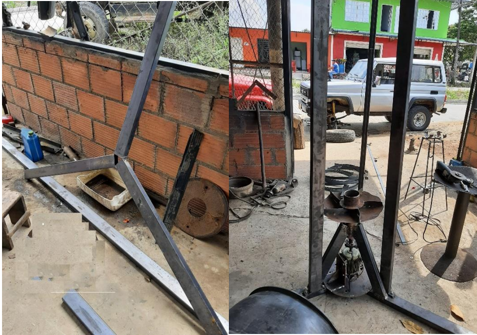
Figura 7-61 proceso de construcción estructura metálica.
