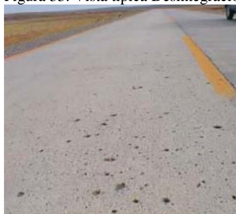
Figura 33. Vista típica Desintegración
