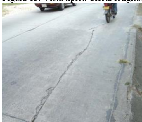
Figura 15. Vista típica Grieta longitudinal
