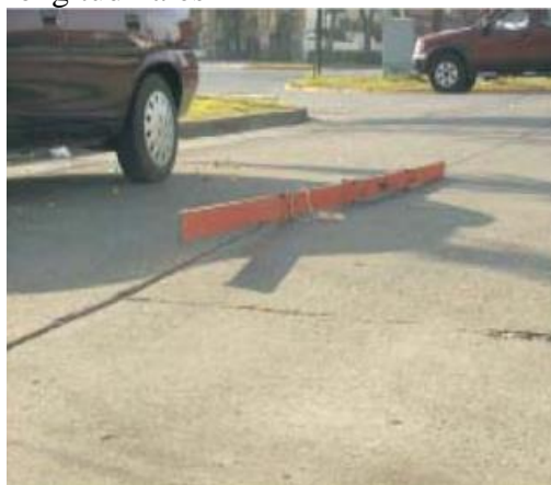
Figura 25. Vista típica Separación de juntas longitudinales
