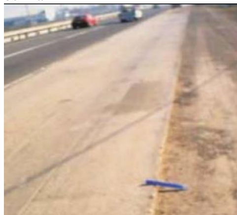
Figura 50. Vista típica Descenso de la berma
