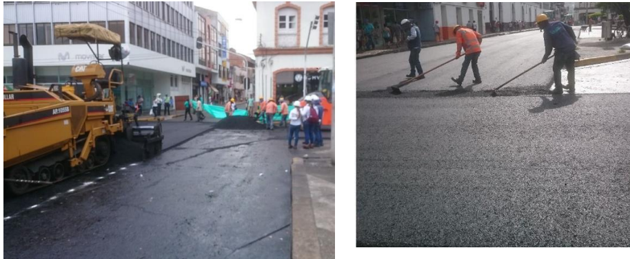
Figura 91. Instalación de mezcla asfáltica
