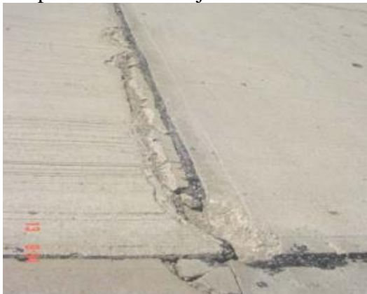
Figura 29. Vista típica planta Desportillamiento de juntas
