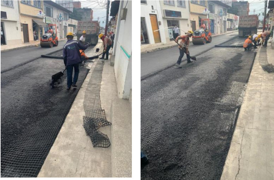
Figura 90. Instalación de geomalla
