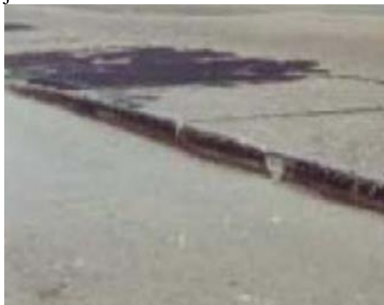
Figura 38. Vista típica Escalonamiento de juntas
