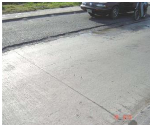
Figura 36. Vista típica Pulimento de losas de concreto
