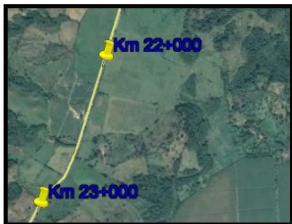
Figura 15. Vista en plano y satelital del tramo 2, Km 23+000 al Km 22+000
