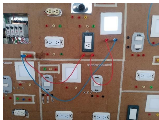
Figura 13 Montaje de prueba de Toma con interruptor Fuente: elaboración propia
