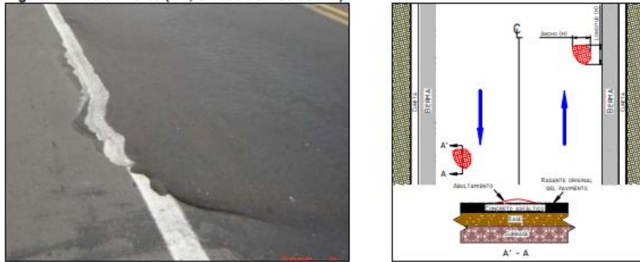
Figura 23, Abultamiento (AB, Unidad de medida:m2)
