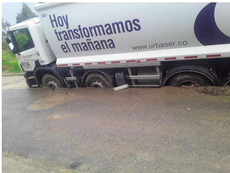
Figura 4, Falla estructural por posible falla en el diseño vial.
