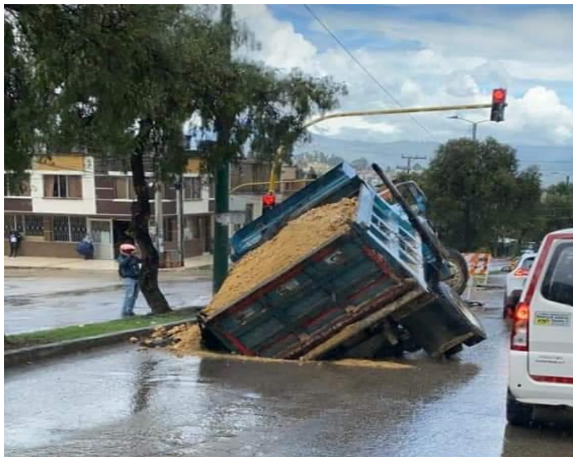
Figura 8, Accidente por deterioro de malla vial, barrio Boyacá (Duitama)
