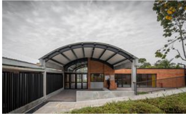
Imagen 5: fachada principal del centro de desarrollo infantil El Porvenir
