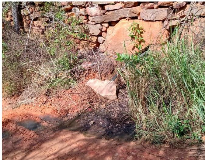
En la anterior imagen se puede notar como el reboce de un pozo séptico hace que las aguas negras fluyan sobre la superficie del terreno, esto debido al mal manejo o inadecuada instalación, asimismo no cuenta con un pozo o campo de infiltración para que el agua filtrada se incorpore de nuevo a la tierra, lo que provoca malos olores y contaminación del medio ambiente.
