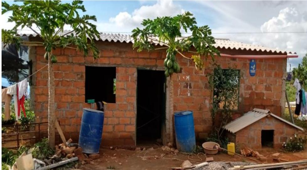
Por otra parte, la vivienda cuenta con canecas para la captación de agua lluvia, sin embargo, se hace muy laborioso a la hora de ser utilizada en la vivienda ya que no cuenta con una red que esté conectada al sistema hidráulico y permita la fácil utilización de esta agua, que se puede utilizar para los sanitarios, lavadero, riego y para el consumo animal.
