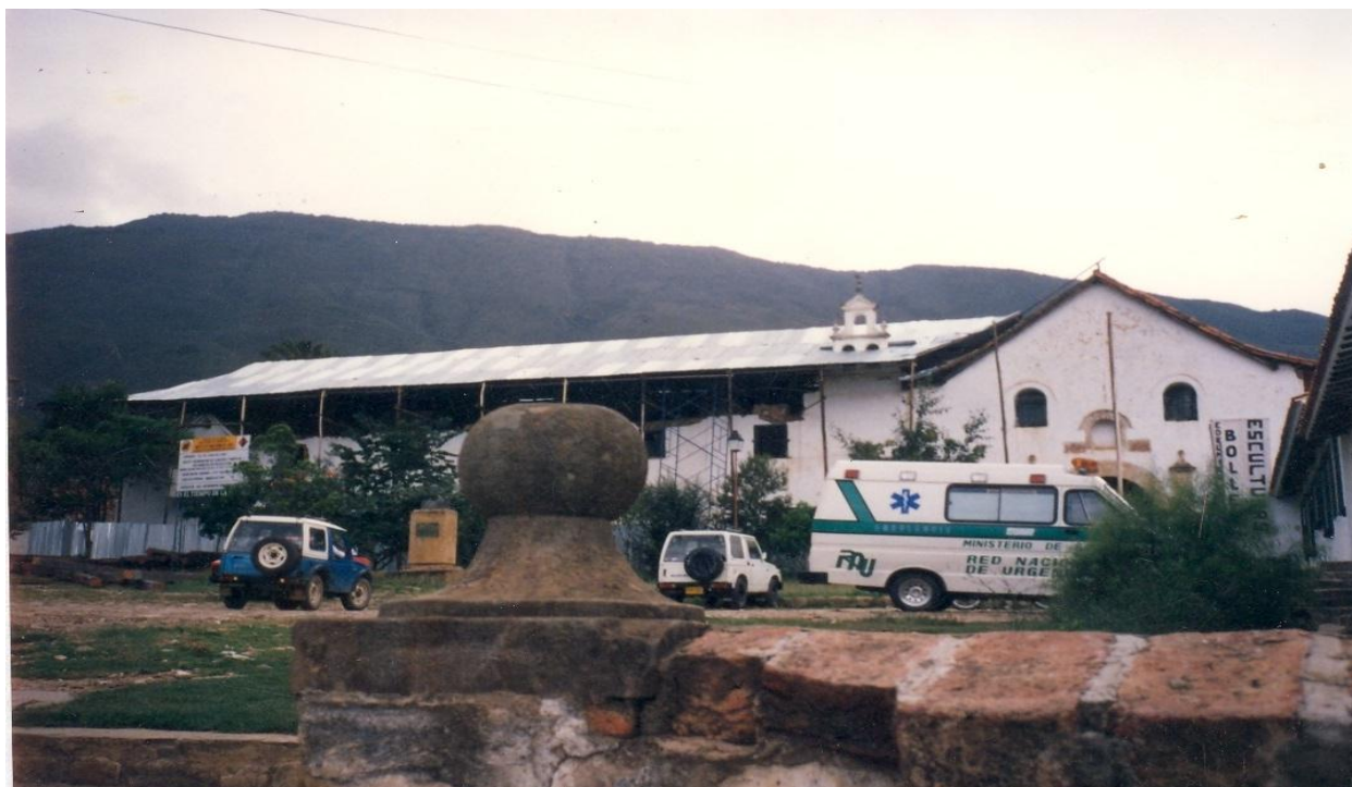
Figura 41 Año 1997 Obra de restauración Invias Fuente: Reseña San Francisco V de L, 2015
