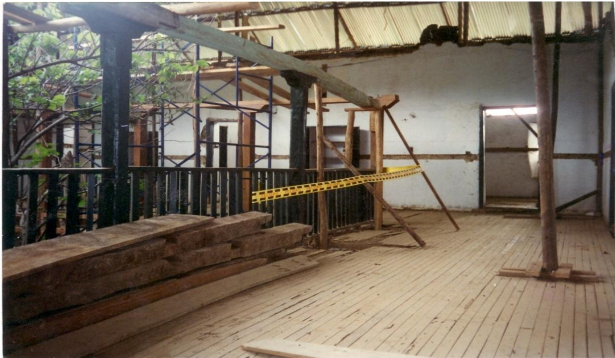
Figura 42 Año 1997 Obra de restauración Invias Fuente: Reseña San Francisco V de L, 2015.
