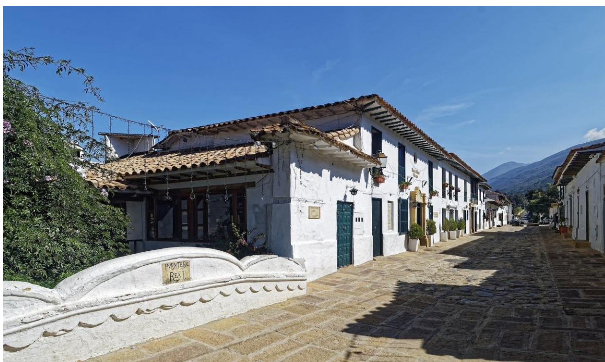
Figura 18 Trabajo de Campo Fuente: Elaboración Propia (2021)
