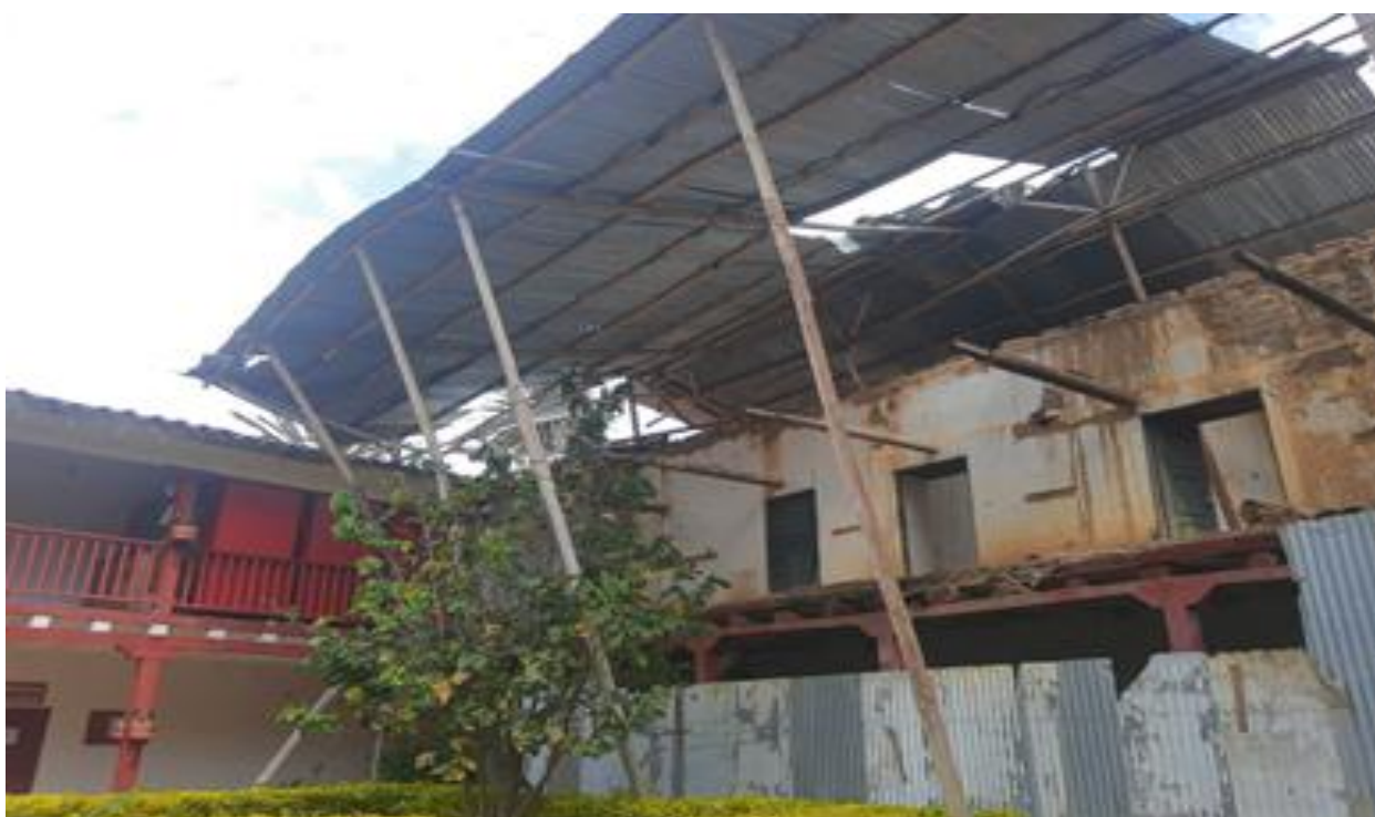
Figura 16 Trabajo de Campo Fuente: Elaboración Propia (2021)
