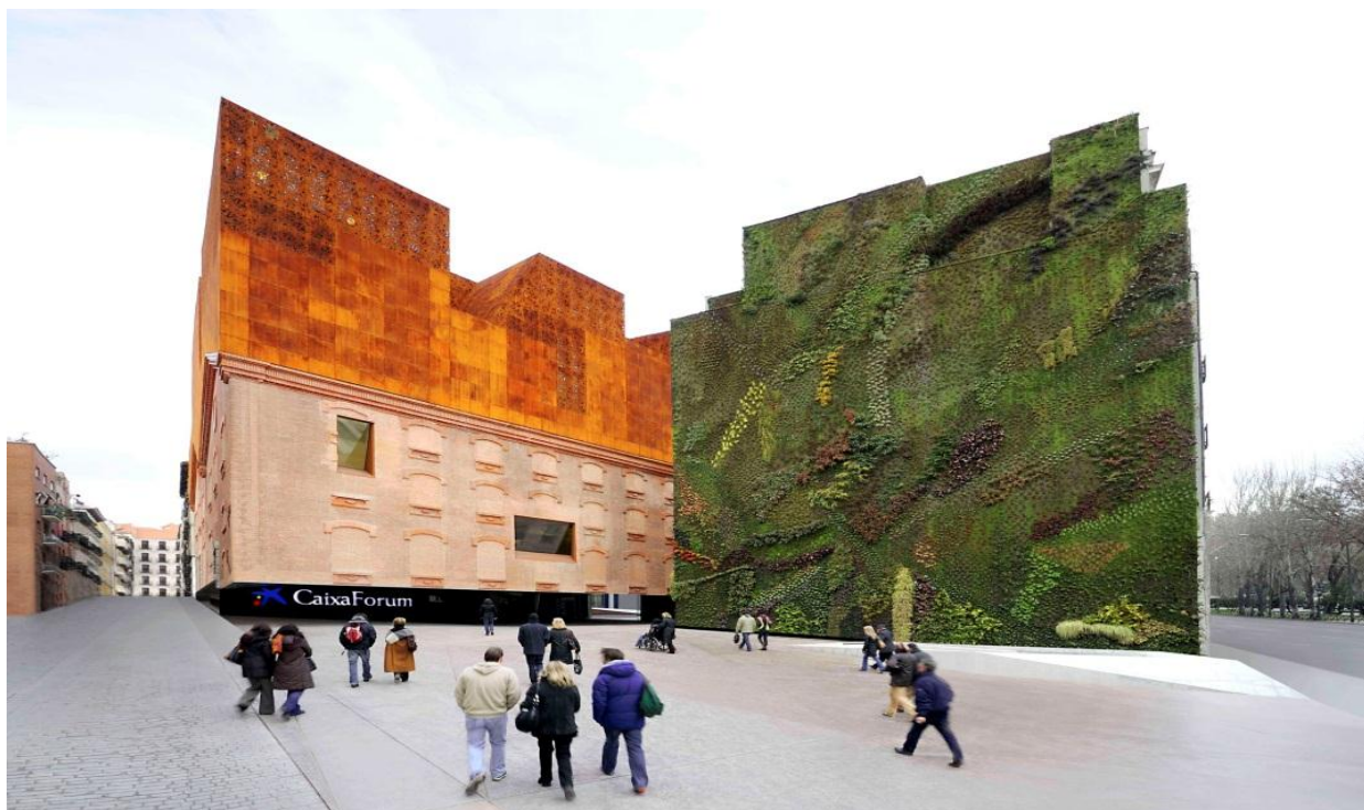
Figura 10 Fachada principal Caixa Forum Madrid España Fuente: Internet (2016)
