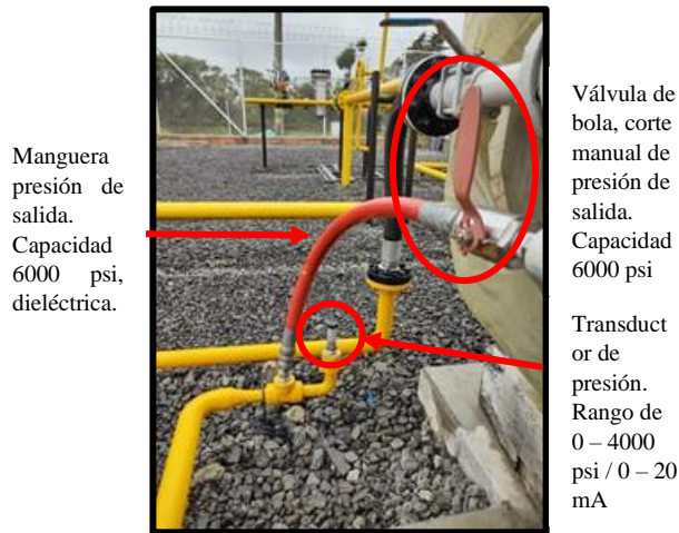
Imagen No 3. Montaje de instrumentos Fuente: Autor
