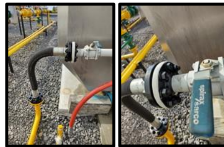
Imágenes No 1 y 2. Montajes de tuberías Fuente: Autor
