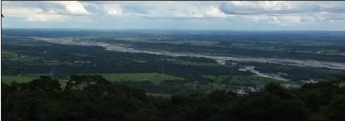
Fotografía 5-15: Vista panorámica del Cuaternario
