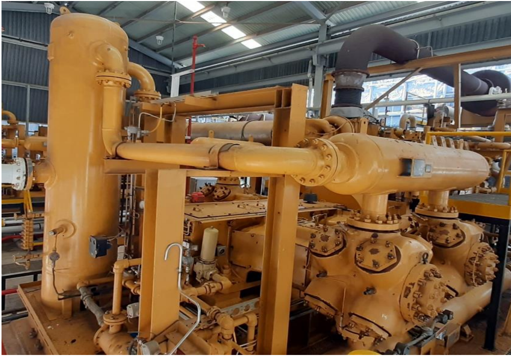
Figura 5. 5. Compresor Reciprocante tipo HOS, marca Dresser-Rand
