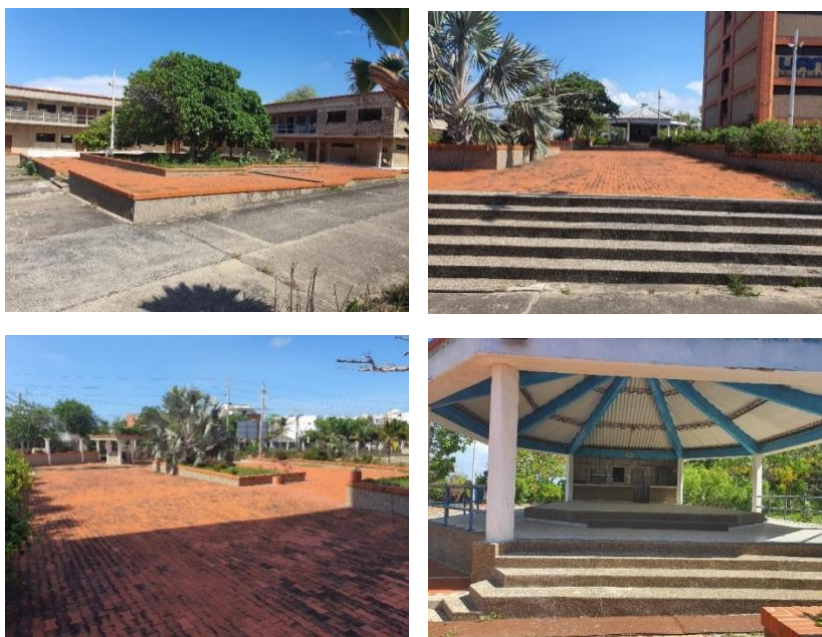
Ilustración 7 Falta de punto de recolección 2
