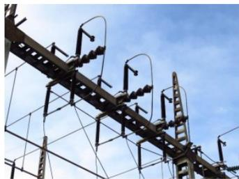
Figura 1. Seccionador de transferencia abierto (superior), seccionador de línea cerrado (inferior), nivel de tensión 115 kV
