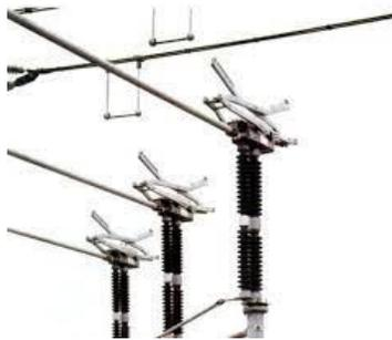
Figura 11. Seccionador de pantógrafo
