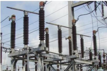
Figura 5. Seccionadores de apertura central
