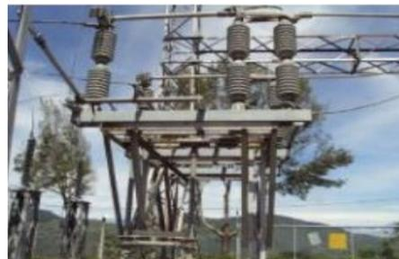
Figura 7. Seccionadores de apertura vertical
