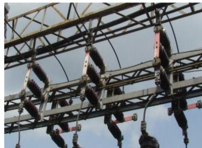
Figura 2. Seccionadores de barra y de línea
