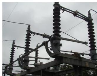
Figura 3. Seccionadores de línea con función de puesta a tierra
