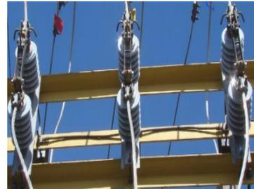
Figura 6. Seccionadores de cuchilla
