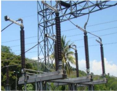
Figura 4. Seccionador de doble apertura central
