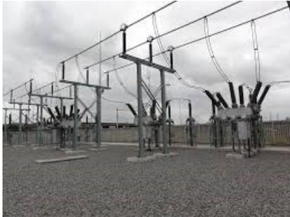
Figura 8. Seccionadores en subestación
