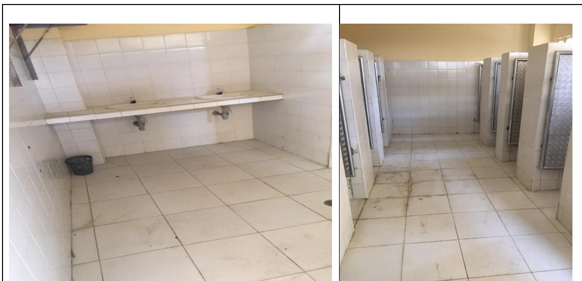
ANEXOS. 2. Baño y lavamanos de la Institución
