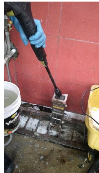
Proceso de limpieza de enfriadores y válvula
