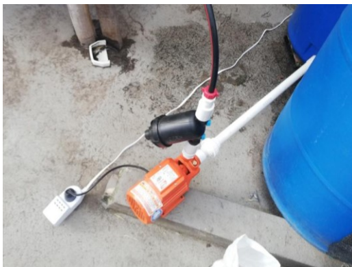
Fig. 7. Instalación del sistema de control de riego
