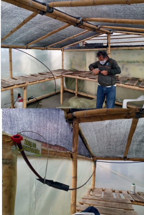
Fig. 6: Adecuación del sistema de riego a la estructura
