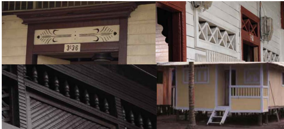
Ilustración 3. Calados y Ornamentos - Viviendas Palafíticas Buenaventura Fuente. Libro, Vivienda y Arquitectura Tradicional en el Pacífico colombiano
