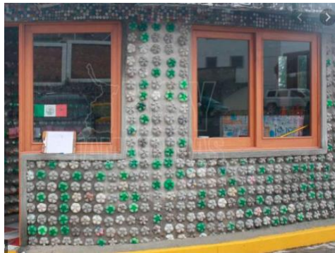
Figure 17 Escuela de ingeniería civil de la universidad Cesar Vallejo Chimbote presento el proyecto "Diseño y construcción de vivienda ecológica en unidades de Albañilería tipo PET para zonas de crecimiento urbano "
