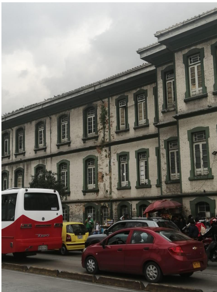
Imagen 2. Deterioro del monumento arquitectónico.
