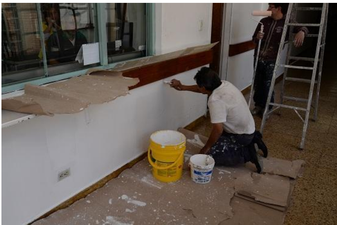
Imagen 7. Obras en el Materno Infantil.
