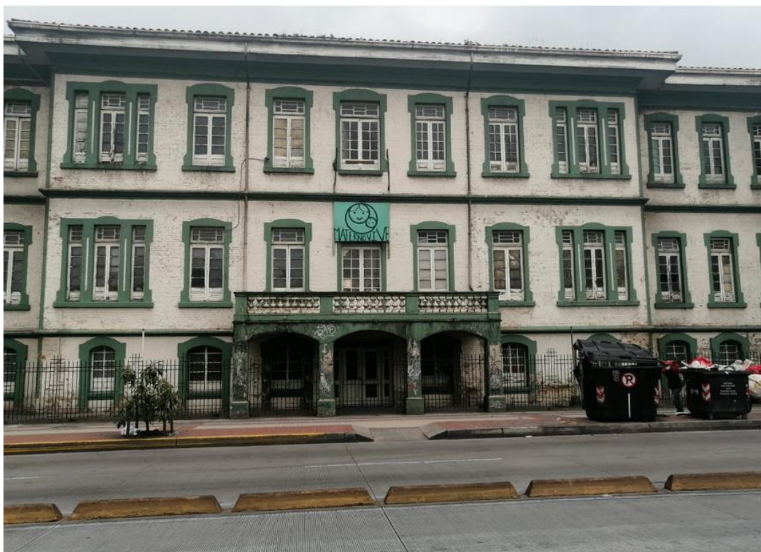
Imagen 6. Estado actual de la fachada principal de Instituto Materno Infantil.
