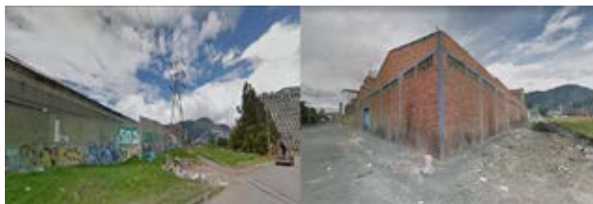
Imagen 2: Estado de las edificaciones del sector. [Imagen]. Fuente: Google street view (2019)
