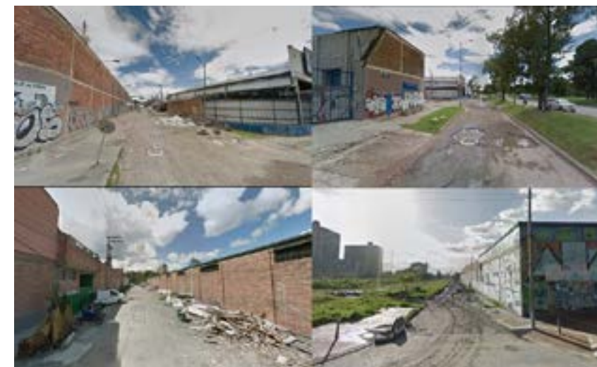
Imagen 4: Deterioro vial por residuos sólidos. [Imagen]. Fuente: Google street view (2019)
