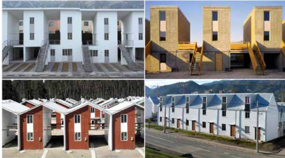
Figura-19 Proyectos de vivienda social Propuestos por Elemental S.A.
