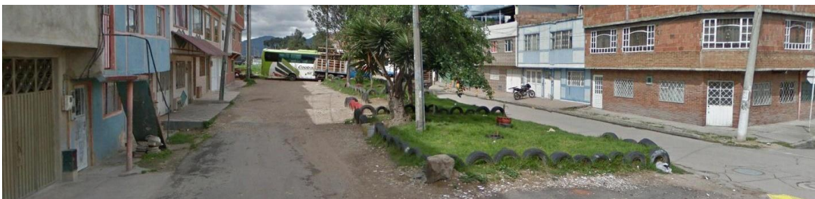
Figura 33 DETERIORO DE LA MALLA VIAL
