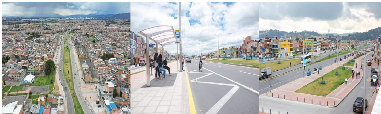
Fotografía 5. Avance de Obra Av. El Tabor
