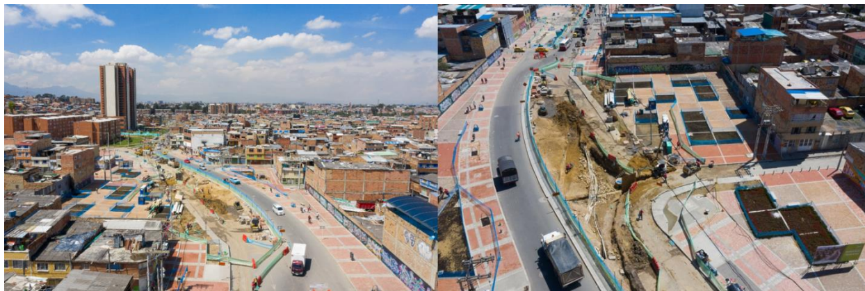
Fotografía 4. Vía Rincón en ejecución
