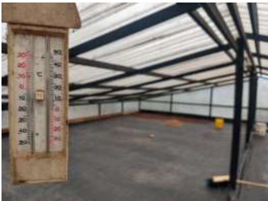
Imagen 8. Secadero en láminas de policarbonato vereda El Tablón, La Plata -Huila
