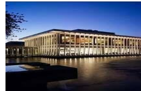
Figura 17. Sede Corporativa de Johnson Controls en Glendale, Winsconsin, Estados Unidos. Fuente. (Controls, 2010)
