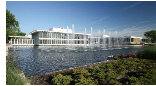
Figura 16. Sede Corporativa de Johnson Controls en Glendale, Winsconsin, Estados Unidos. Fuente. (Controls, 2010)
