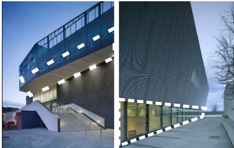
Ilustración 18. Fachadas y voladizos del centro y congreso cultural
