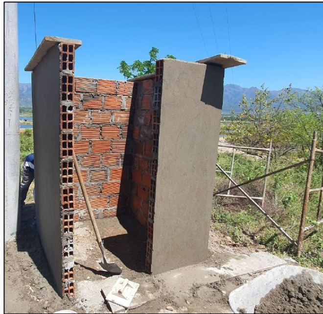
Figura 2-46: Obra civil de cuarto para tablero de distribución en baja tensión.
