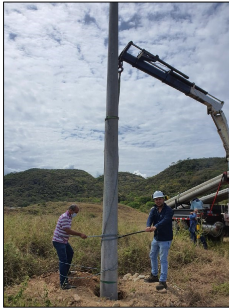
Figura 2-42: Montaje de posteria 750 kg y 1050 kg de 12 metros.
