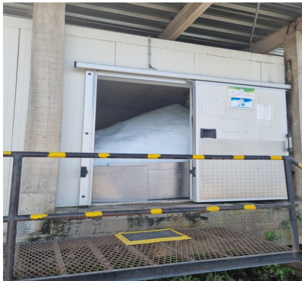
Figura 3-8: Montaje de la máquina hielera nivel uno y dos.
