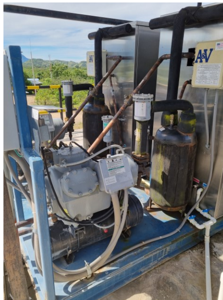
Figura 2-61: Compresores Máquina Hielera AV400CR.
