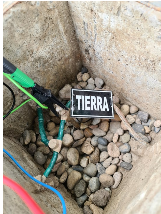
Figura 3-3: Caja de inspección 30x30 cm para medir la resistencia de la malla a tierra.
