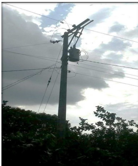
Figura 1-3: Monofásica – En Volado – Doble Retención.
