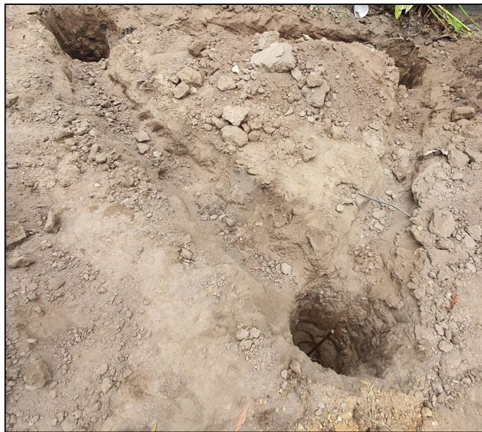
Figura 2-52: Montaje de varillas COPPERWELD cobre-cobre S.P.T.
