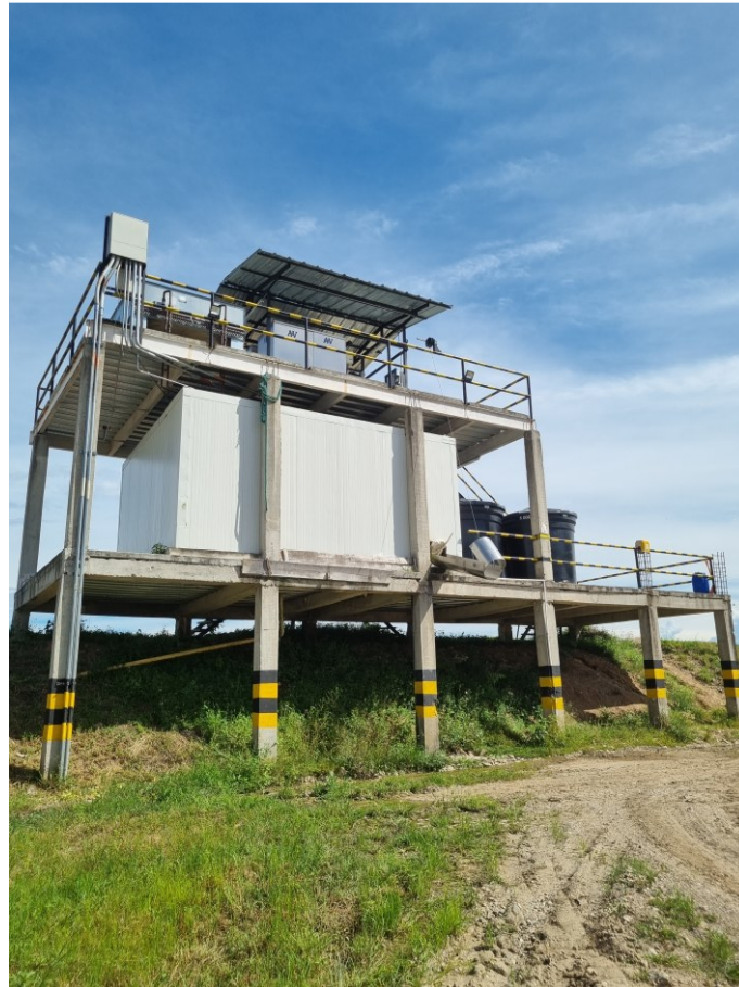
Figura 3-6: Montaje de la máquina hielera nivel uno y dos.
