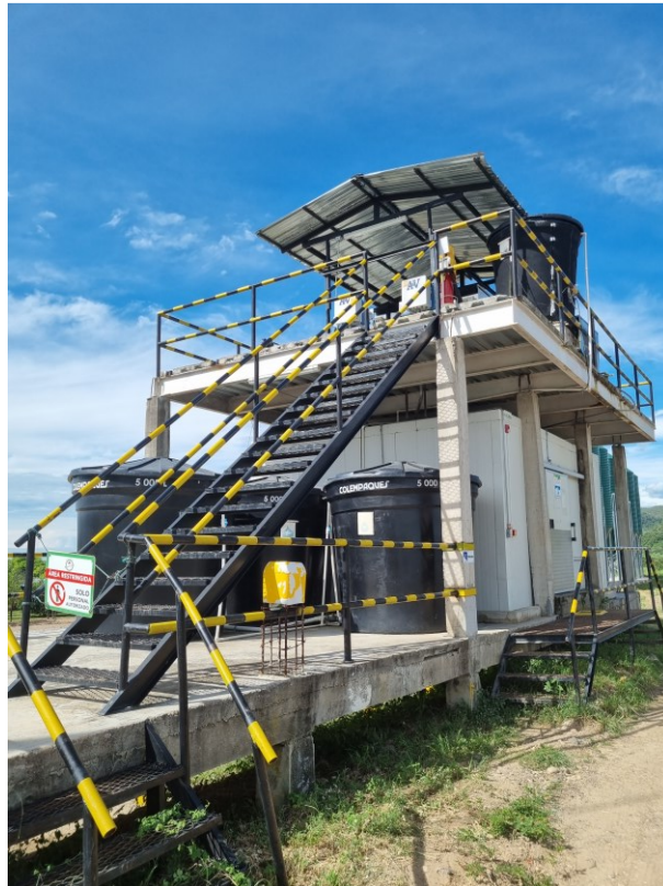
Figura 3-7: Montaje de la máquina hielera nivel uno y dos.
