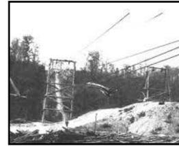
**Cable Aéreo:** sistemas compuestos por cables, donde los vehículos están suspendidos del tipo de mecanismo a ser utilizado
