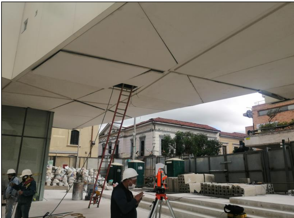
Anexo 17. Registro fotográfico 2. Avance parcial del 95% cielo raso GRC
