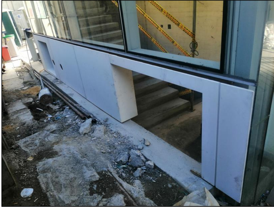
Anexo 31. Registro fotográfico 1. Paneles instalados fachada Crr 6ta teatro Colón
