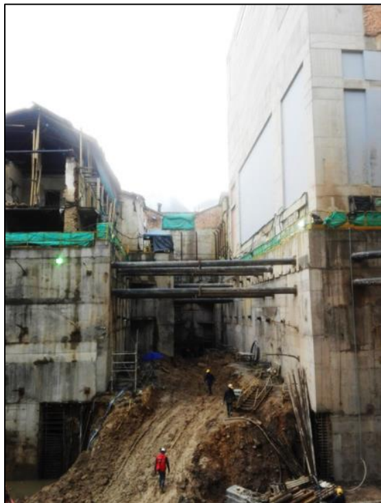
Figura 4. Muros de contención Etapa III Teatro Colón
