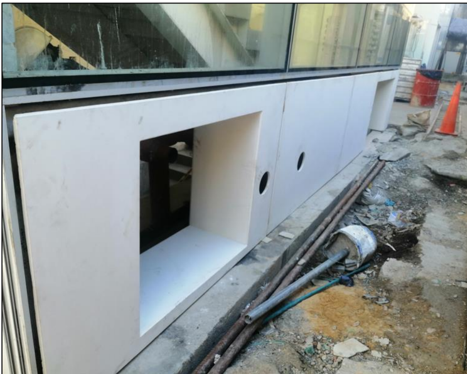
Anexo 32. Registro fotográfico 2. Paneles instalados fachada Crr 6ta teatro Colón
