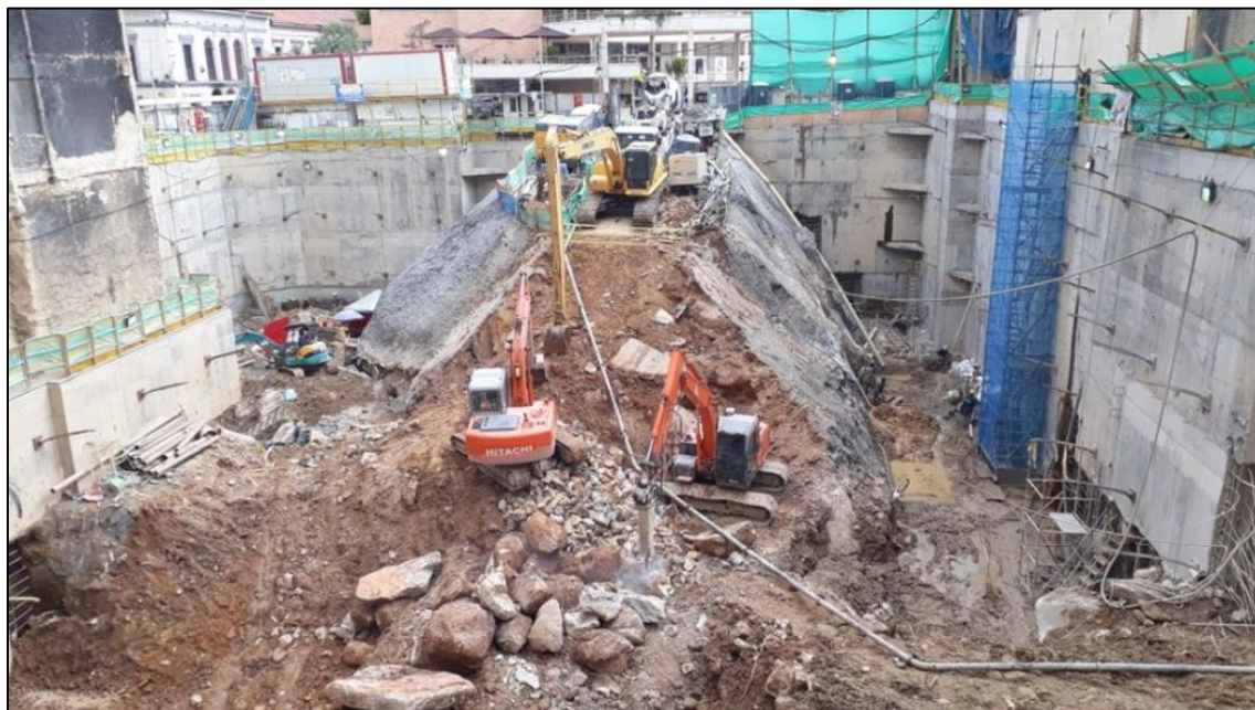
Figura 5. Obras de excavación Etapa III Teatro Colón
