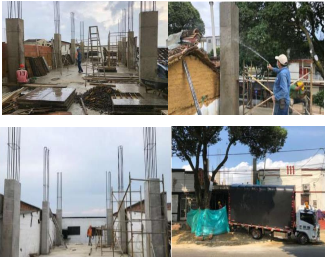
Figura 46. Segunda visita a campo. Fuente elaboración propia
