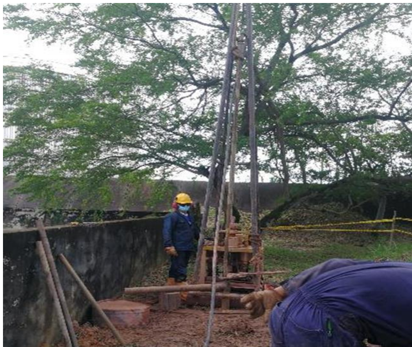
Figura 29 Maquinaria instalada en la ubicación sondeo PQ-3 S-10.
