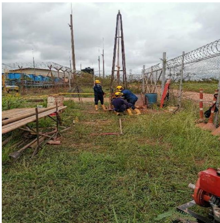
Figura 28 Maquinaria instalada en la ubicación sondeo PQ-3 S-1
