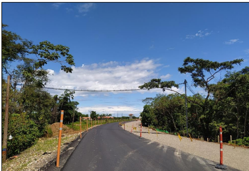
Figura 6 Paso de fauna terminado (Consorcio Carreteras para la biodiversidad)
