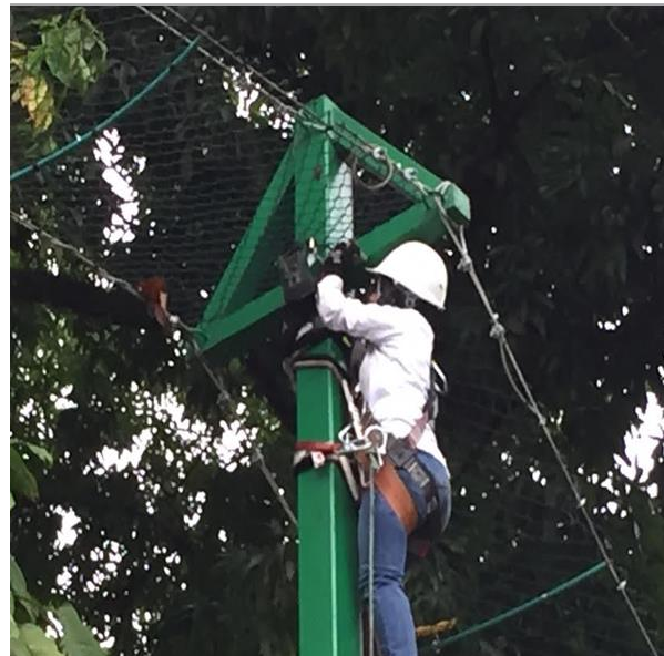
Figura 8 Instalación cámara trampa en paso de fauna (Elaboración propia)
