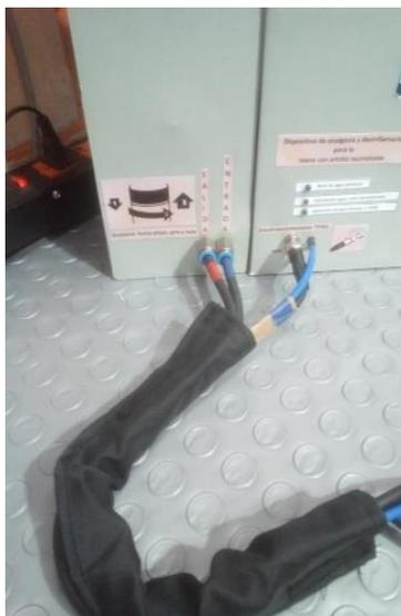
**Figura 3-40.** Forro de protección para mantener uniformes las conexiones.
