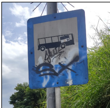
Figura 17. Estado de la señalización actual.
