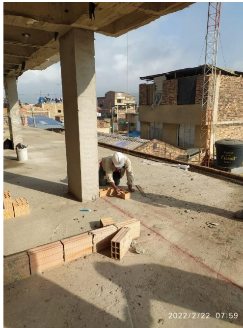
Figura 27 Trazado de muros sobre placa
