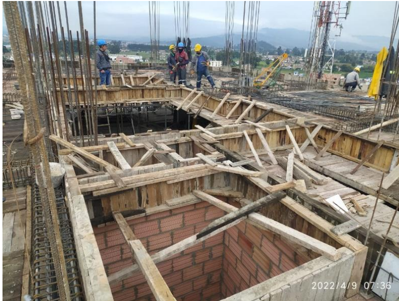
Figura 16 Instalación de testeros
