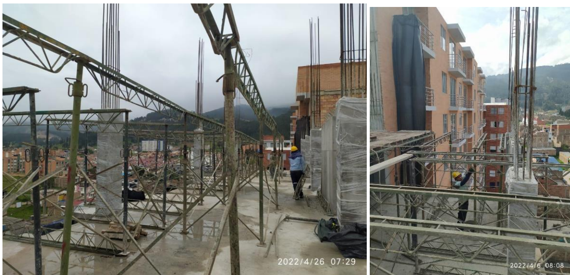
Figura 12 Instalación de parales y cerchas
