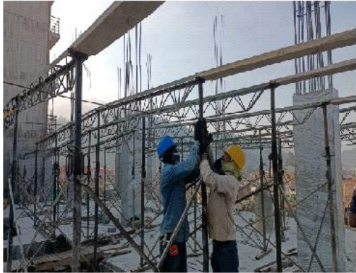
Descripción: Instalacion de parales y cerchas
