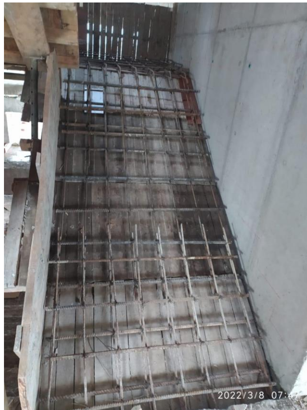
Figura 23 Disposición de acero escalera
