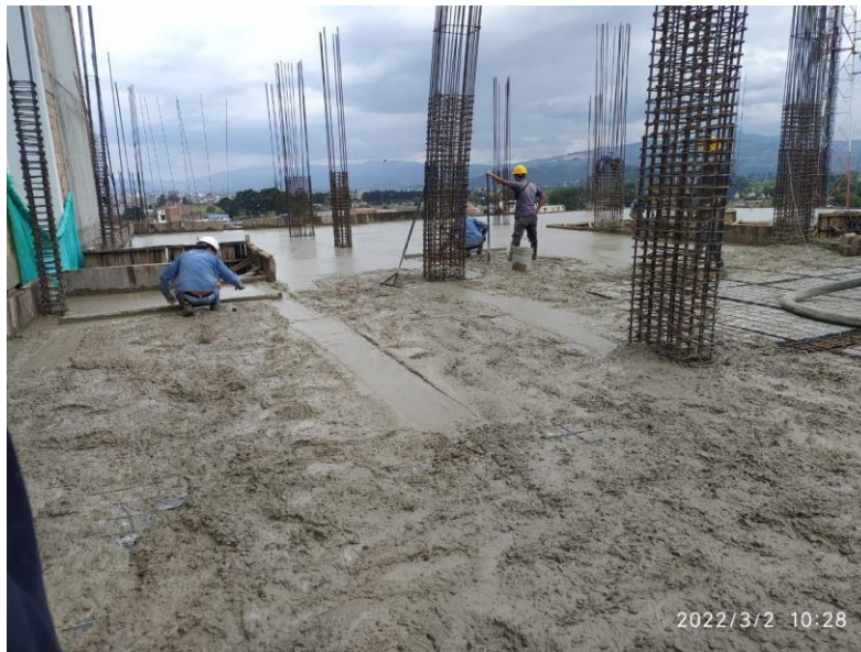
Figura 22 Nivelación de concreto en placa
