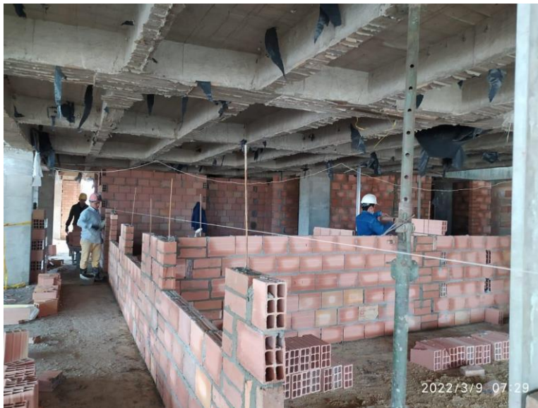
Figura 26 Mochetas para ventanas internas
