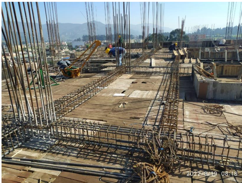
Figura 17 Amarrado de acero de vigas
