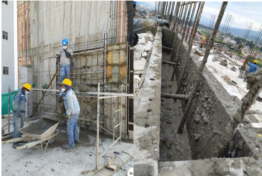
Figura 10 Fundida de muros pantalla
