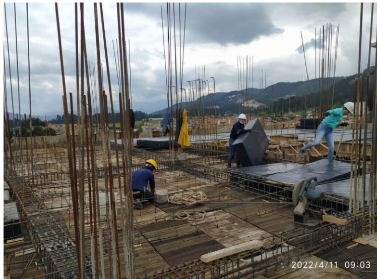
Figura 19 Instalación de casetón
