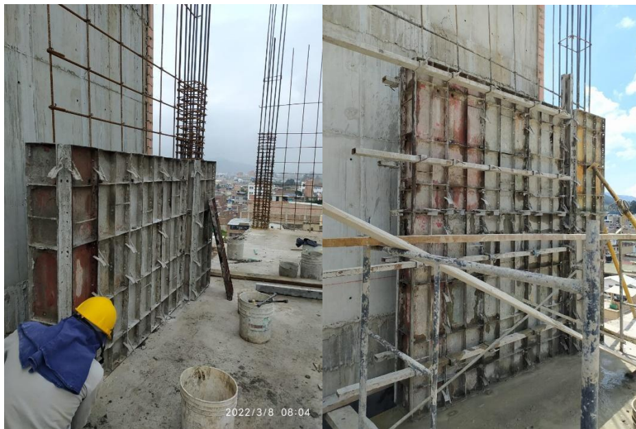
Figura 9 Encofrado de muros pantalla
