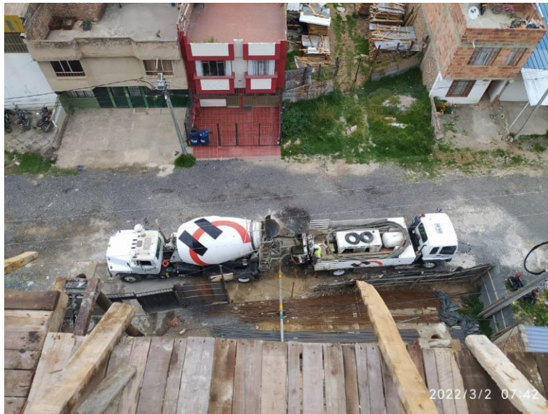
Figura 21 Mixer y bomba estacionaria para fundida
