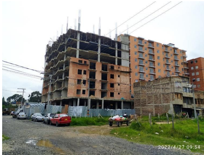
Figura 29 Vista general proyecto 27 de abril
