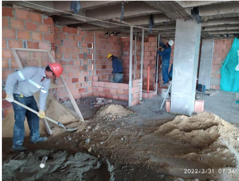
Figura 25 Instalación de boquilleras y levantamiento de muros en bloque N°4
