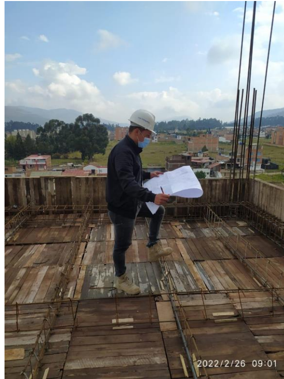
Figura 18 Revisión de acero según planos estructurales
