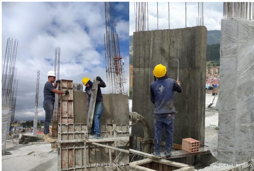
Figura 11 Desencofrado y curado de muros pantalla
