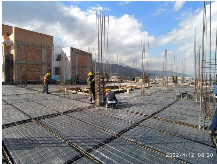
Figura 20 Instalación de malla electrosoldada
