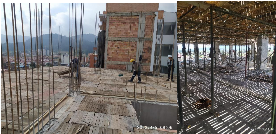
Figura 14 Limpieza y nivelación inferior de cama base
