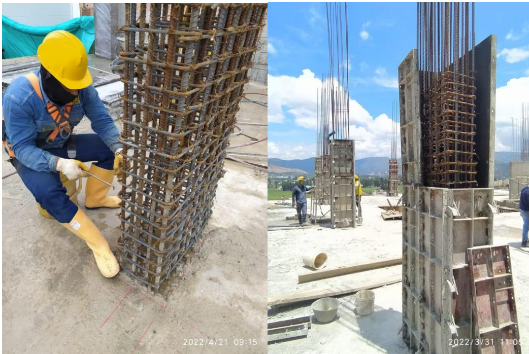
Figura 6 Encofrado de columnas
