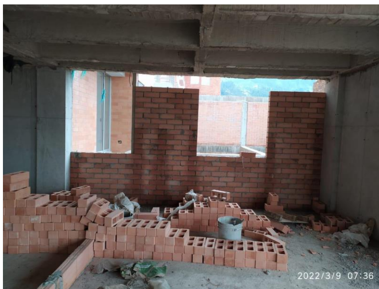
Figura 28 Muros de fachada en ladrillo estructural
