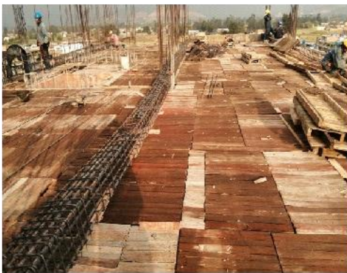
Descripción: Amarrado de acero vigas
